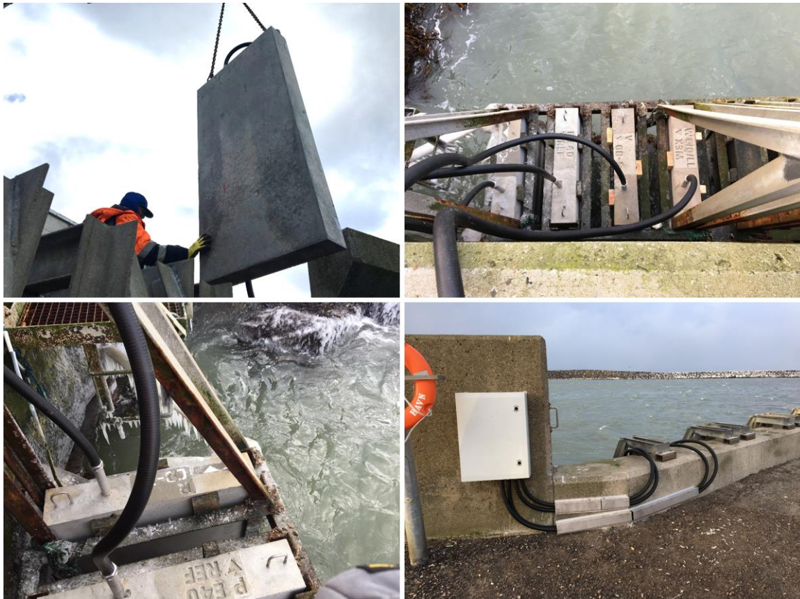
Figur 13. Installering af blokke i Hirtshals Havn. P: Referencen, R: GB-3, V: GB-5 og W: X3M.
