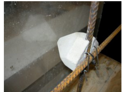
Løsningen på problemet kunne være en afstandsholder som denne med en ru overflade, som binder bedre til betonen. Det er et af de mange forskningsprojekter, der for tiden er i gang for at forbedre levetiden for betonkonstruktioner. (Foto: Teknologisk Institut)
