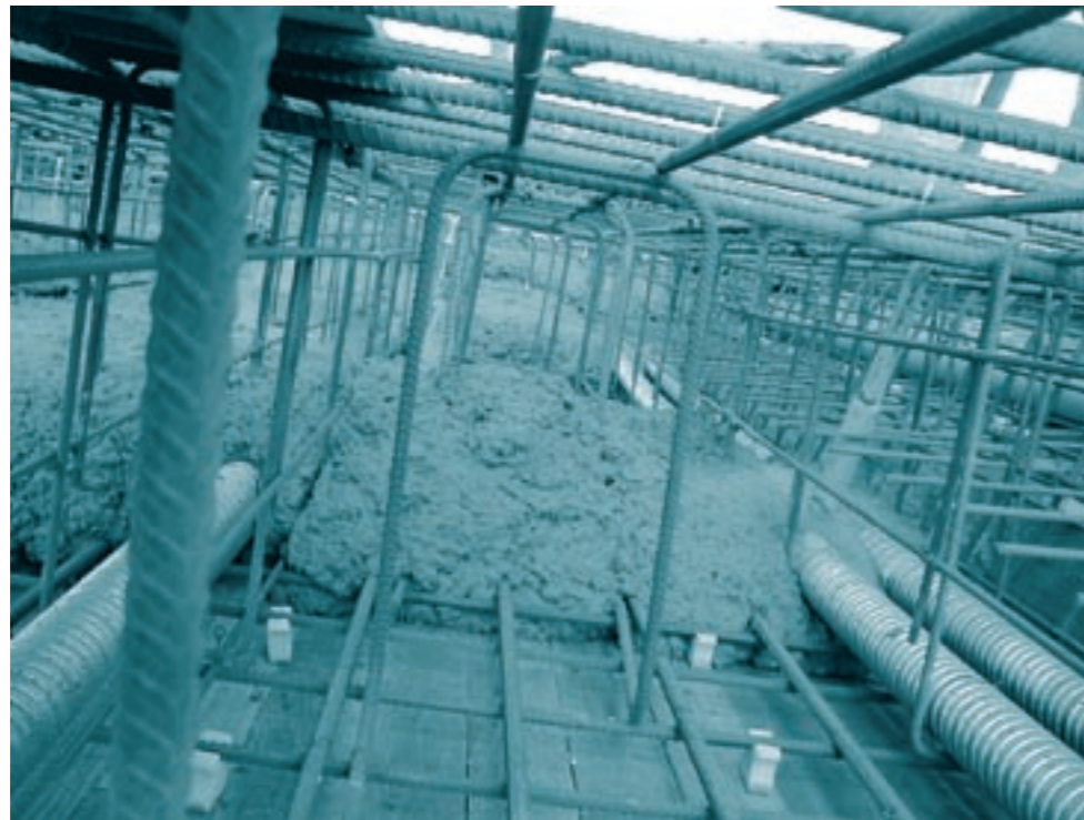
Udstøbning af fundament i Bro 34.
