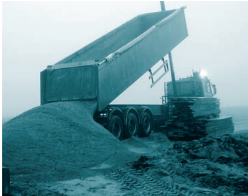
Opfyldningsarbejder ifm. Bro 34.
