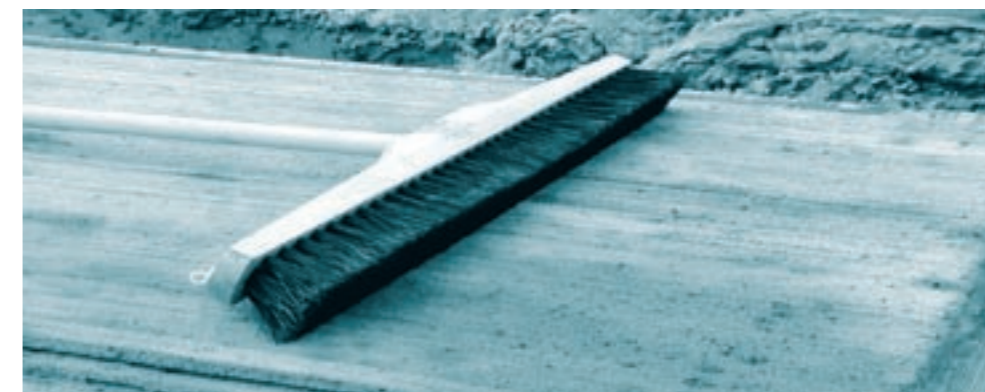
Her gennemføres afkostningsforsøg, da brodækket på Bro 34 opføres uden isolering.
