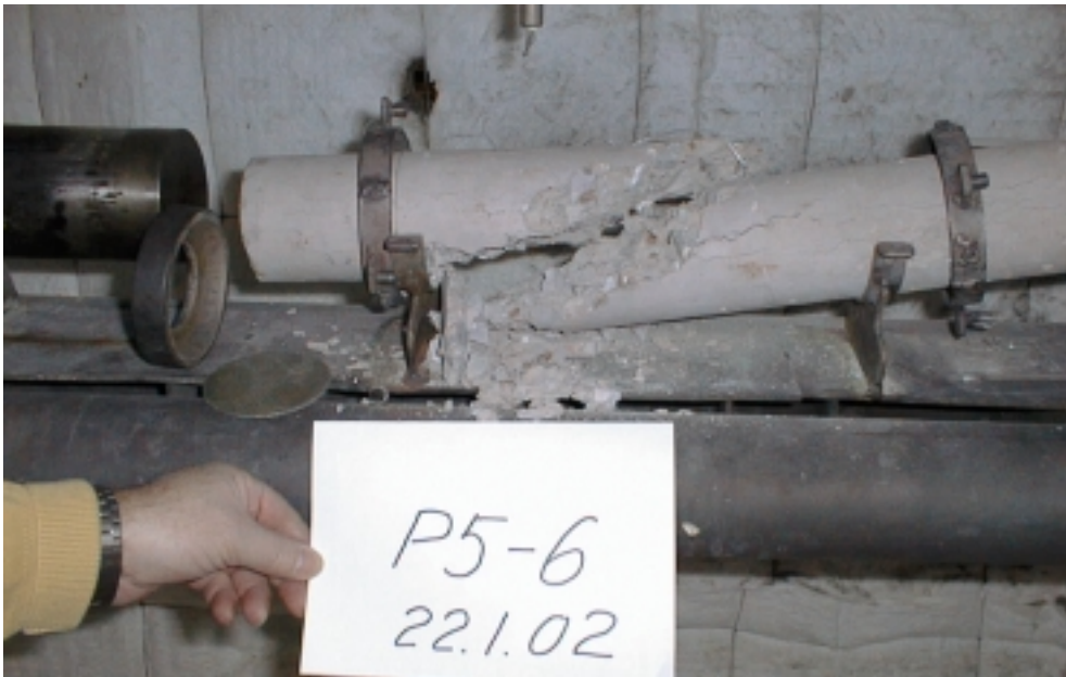
Fig. J.3: Prøveemne P5-6 efter afkøling. Brud skete under konstant trykspænding på ca. 9 MPa ved en temperatur på ca. 570 °C.
