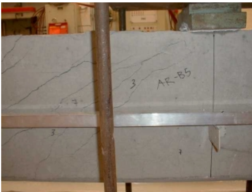
Figur B-3: Bjælke AR-b5. Skrårevner stråler ud fra understøtningspunkt i bjælkens overside.
